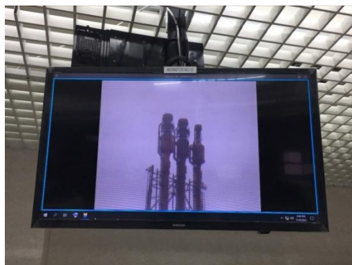
ภาพที่ 3.2-4 CCTV เพื่อตรวจสอบระบบ Flare
