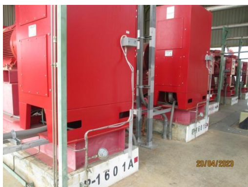
ภาพที่ 3.2-47 แหล่งน้ำสำรองดับเพลิง และเครื่องสูบน้ำดับเพลิง
