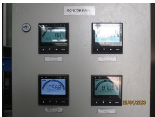
ภาพที่ 3.2-15 Conductivity Online บริเวณระบบ Reverse Osmosis
