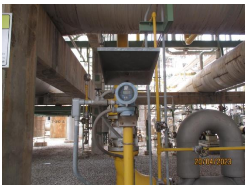
ภาพที่ 3.2-40 Flammable Gas Detector
