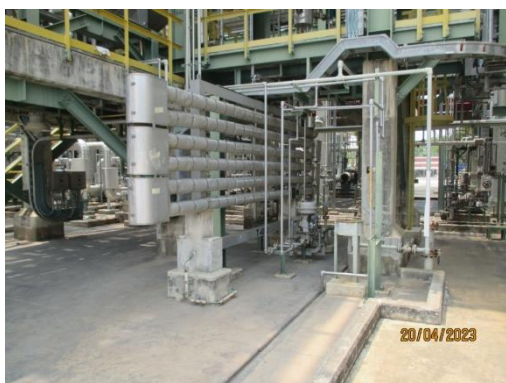
ภาพที่ 3.2-9 Wastewater Stripper
