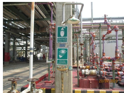
ภาพที่ 3.2-41 ฝักบัวฉุกเฉิน และที่ล้างตา
