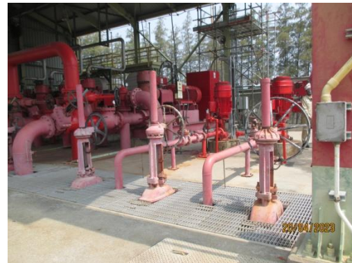
ภาพที่ 3.2-47 แหล่งน้ำสำรองดับเพลิง และเครื่องสูบน้ำดับเพลิง (ต่อ)
