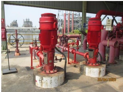
ภาพที่ 3.2-47 แหล่งน้ำสำรองดับเพลิง และเครื่องสูบน้ำดับเพลิง (ต่อ)
