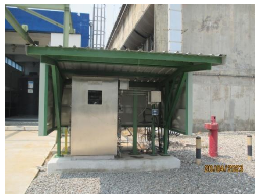
ภาพที่ 3.2-53 Conductivity Online ที่ Cooling Blowdown
