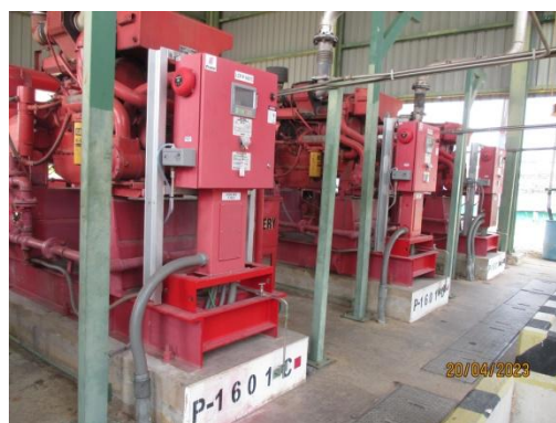
ภาพที่ 3.2-47 แหล่งน้ำสำรองดับเพลิง และเครื่องสูบน้ำดับเพลิง
