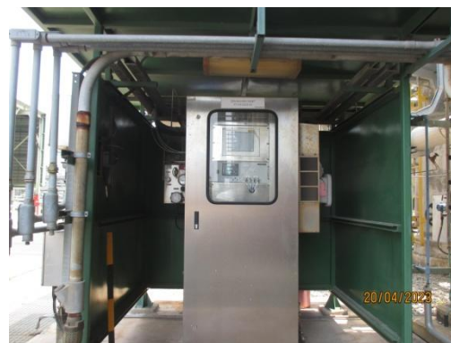
ภาพที่ 3.2-5 อุปกรณ์ตรวจวัดมลพิษอัตโนมัติแบบต่อเนื่อง (CEMs)
