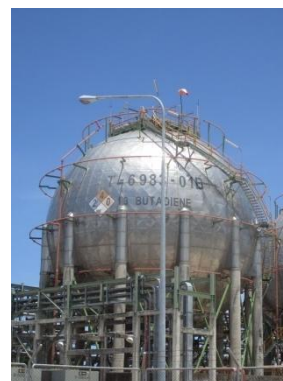
ภาพที่ 3.2-49 ถังเก็บก๊าซ 1,3-บิวทาไดอิน
