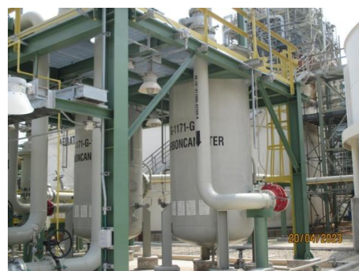
ภาพที่ 3.2-51 ระบบ Activated Carbon Canister
